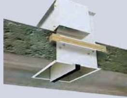
CORTAFUEGO EN FORJADO
